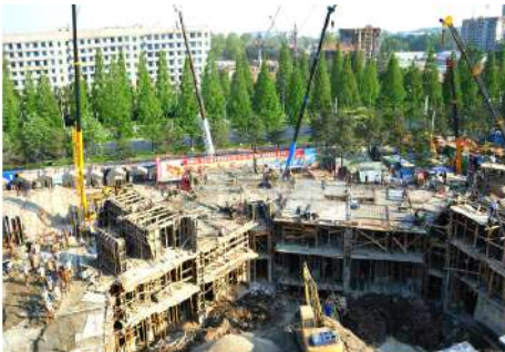
<사진 III-2> 평양의 려명거리 건설
